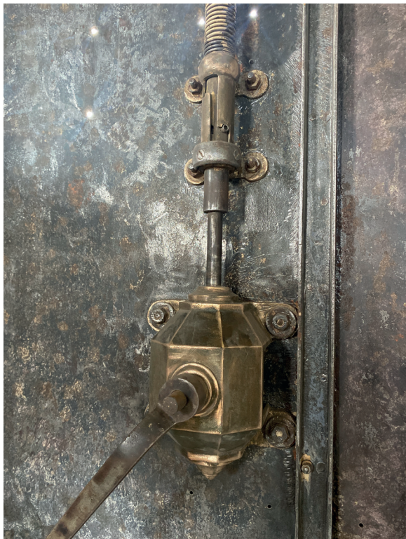
Manivelle et système à crémaillères d'origine restaurée
